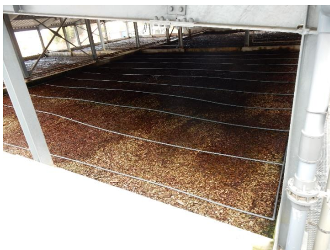
写真 18 : バイオフィルターの木質チップ上部
